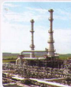
Комплекс глубокой переработки нефти (Россия)
