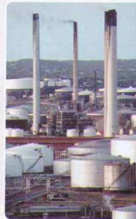
Нефтеперерабатывающий завод на острове Кюрасас (Нидерландские Антильские Острова)
