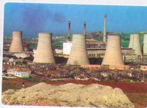
Теплоэлектростанция на западе Албании
