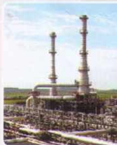
Комплекс глубокой переработки нефти (Россия)
