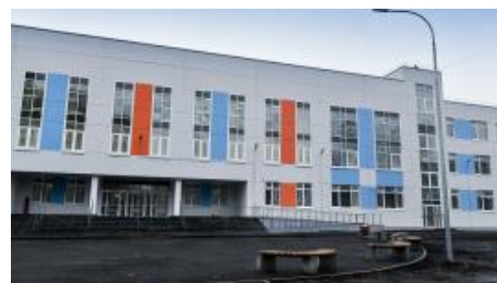
Школа, ул. Юнг Прикамья, г. Пермь, 1 100 мест
